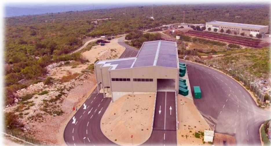
SLIKA: PRETOVARNA STANICA TRESKAVAC SA FOTONAPONSKIM POSTROJENJEM
