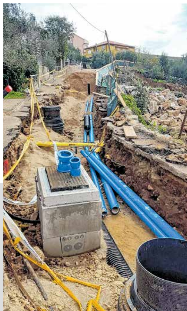
Radovi na izgradnji kanalizacijskog sustava na otoku Krku
