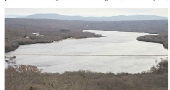
Akumulacija Ponikve u kišnom razdoblju - neupitne količine vode za nadvišenje brane
